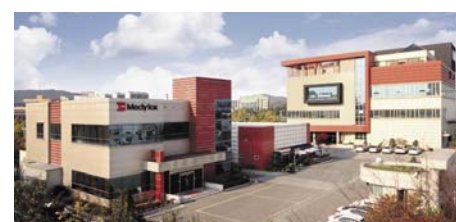
Завод I в г. Очанг
